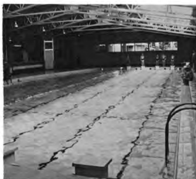
小学校室内温水プール (1974年 3月竣工)
