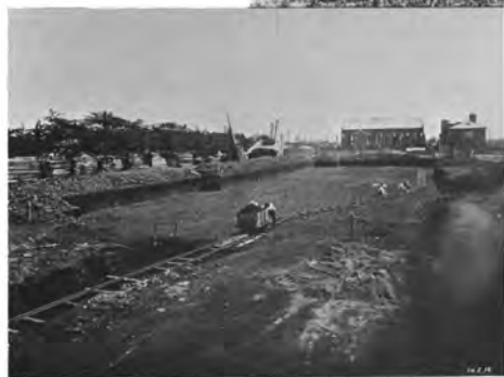
中学校新校舎新築工事現場 (1924年)
